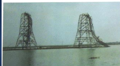
1996年9月,受9615号台风影响,湛江市22万伏高压输电铁塔被拦腰截断
